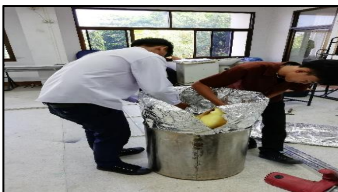
ภาพที่ 3-30 แสดงการติดตั้งไส้ฉนวนกันความร้อนรอบหม้อย้อมสี (ที่มา : วทัญญู บุตรศรี, 2560)
